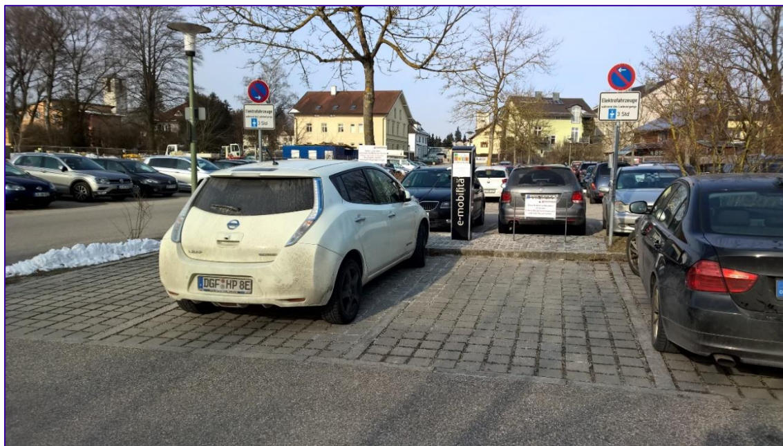
Abbildung 27: Elektroladesäulenstandort Färberanger. Quelle: badenova 2018.
